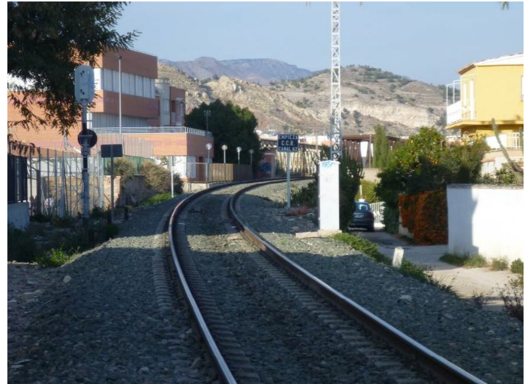
Tramo central de la travesía urbana (pasillo ferroviario muy estrecho)
