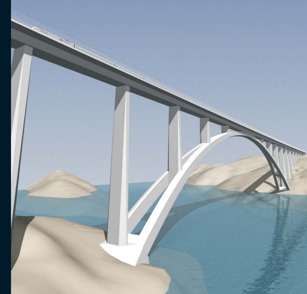
FASE 12: Ejecución de impostas Montaje de las barreras de protección contra la colisión de aves Acabados Puesta en servicio
