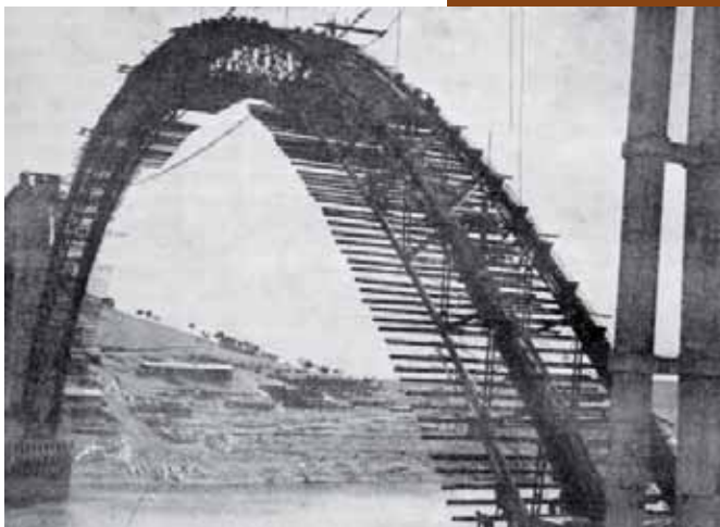
Imagen comparada con el detalle del arco de luz. Colocación de acero y juntas de las dovelas de la rosca número 1 y aspecto actual del Martín Gil.
