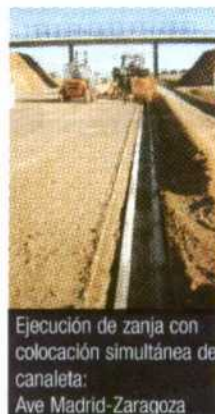
Zanja con colocación simultánea de conductos eléctricos
