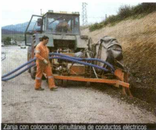
Zanja con colocación simultánea de conductos eléctricos
