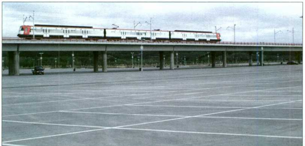
Viaducto sobre el aparcamiento del Parque de Ocio.
