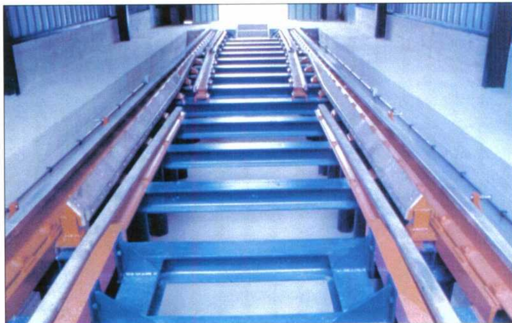
Instalación de cambio de ancho.
