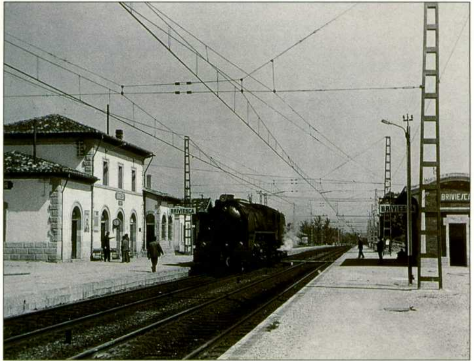
Estación de Briviesca.
