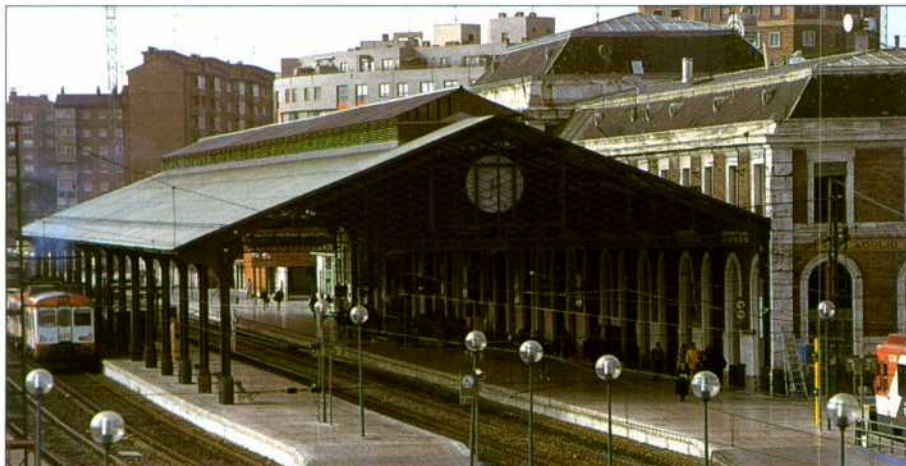
Estación de Valladolid.
