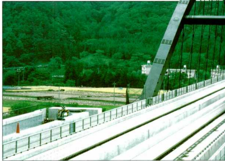
Puente Ogasayama en el tramo de pruebas de la línea de levitación magnética.
