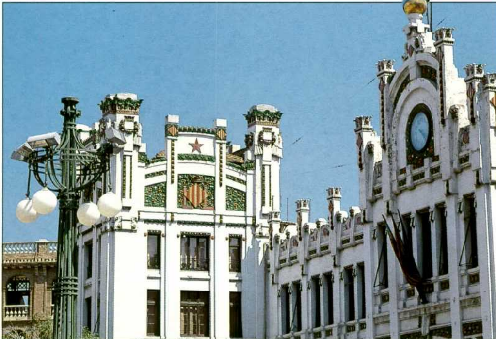
Edificio de la estación de Valencia.
