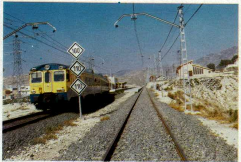
Estación de Elda con la catenaria ya dispuesta. Al fondo, la subestación.
