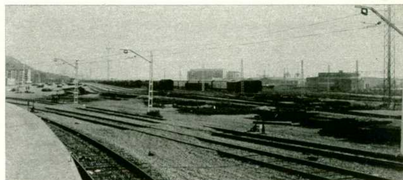
En el curso de 1980 se llevarán a cabo en Barcelona-Casa Antúnez varias obras que quedan pendientes.
