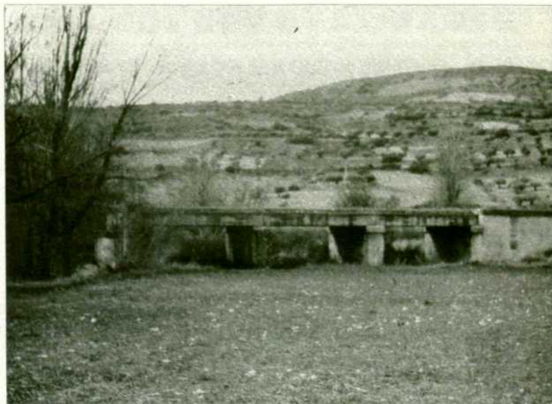
Camino de Carabaña, y a la salida de Orusco, el F. C. estratégico Torrejón-Tarancón contaba con este puente de hormigón sobre el río Tajuña.
