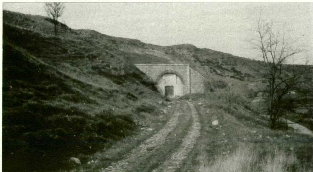
Restos del balasto y túnel situados a la salida de Orusco, en dirección a Villar del Olmo.
