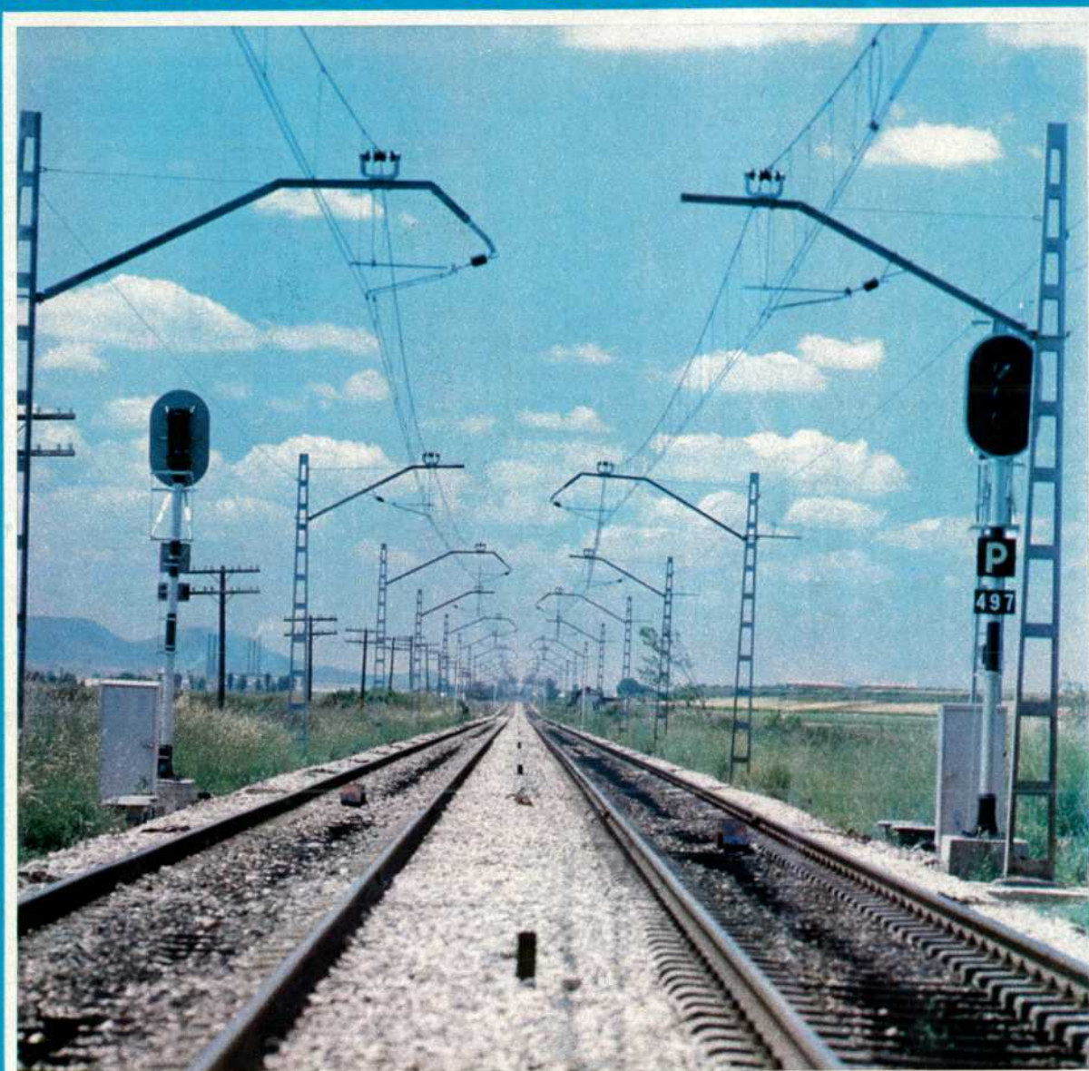
Una perspectiva nueva en la línea férrea del corredor Madrid-Guadalajara, tras su electrificación. (Foto: MAN.)
