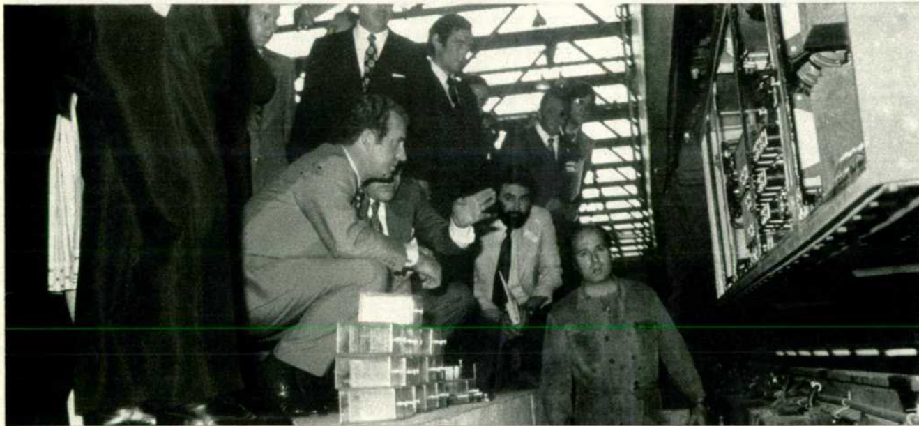
El Príncipe observa con gran atención una de las operaciones de puesta a punto de los trenes en el Centro de Tratamiento Técnico de Fuencarral. (Foto: MAN.)
