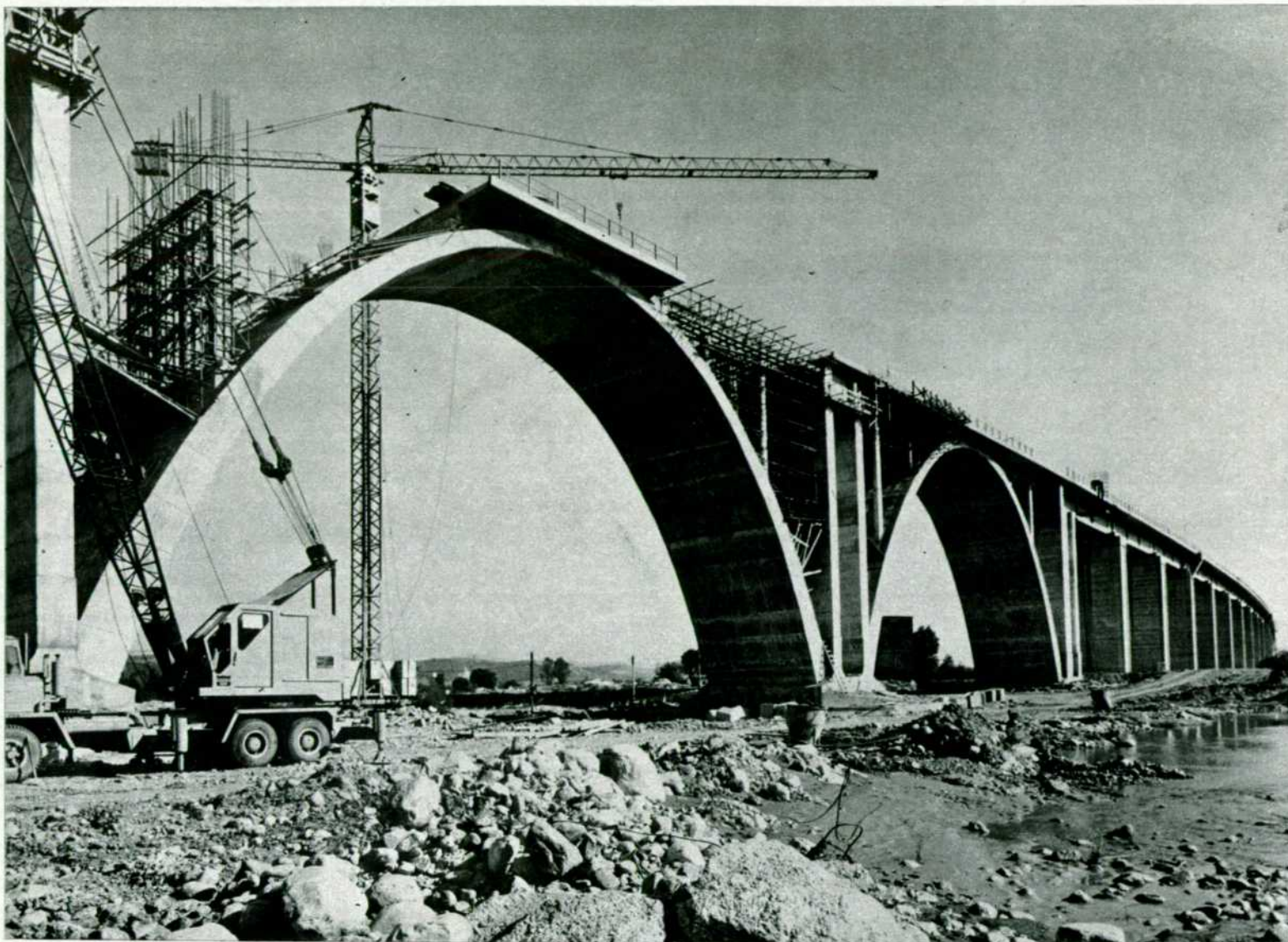
Cinco arcos de 50 metros de luz salvan las aguas del Paglia, camino del Tíber.
