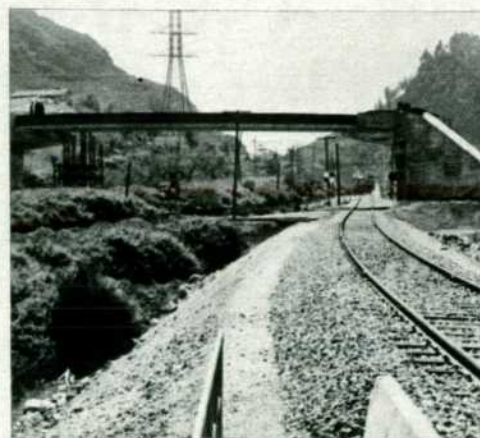
Enlace con la línea de la RENFE Veriña-Aboño, debajo del puente de acceso a la central térmica de Aboño.
