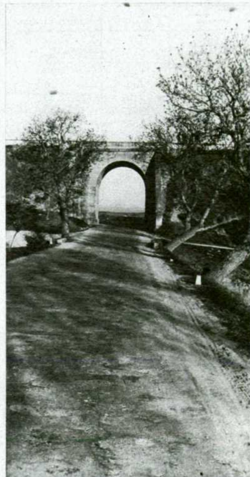
Paso superior sobre la carretera Aranda-Carrión de los Condes.
