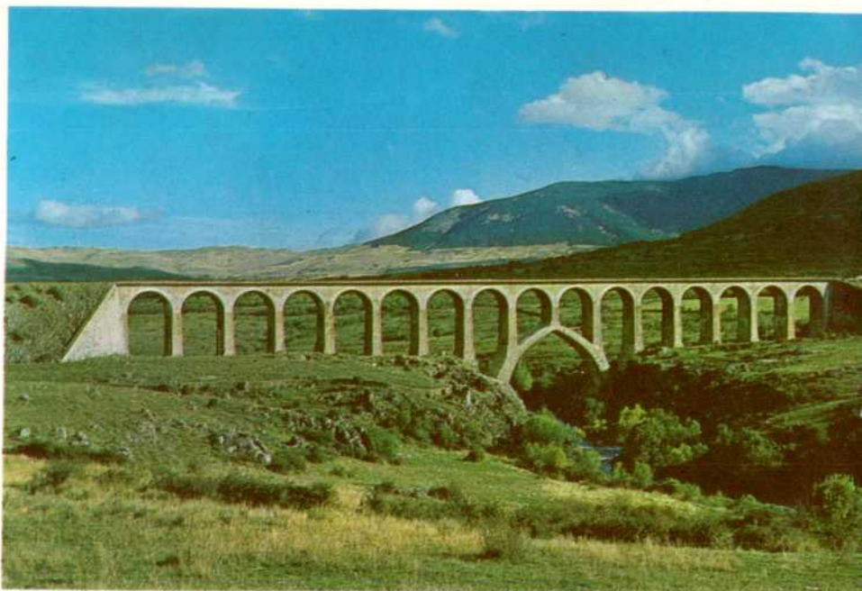
Viaducto sobre el Lozoya.
