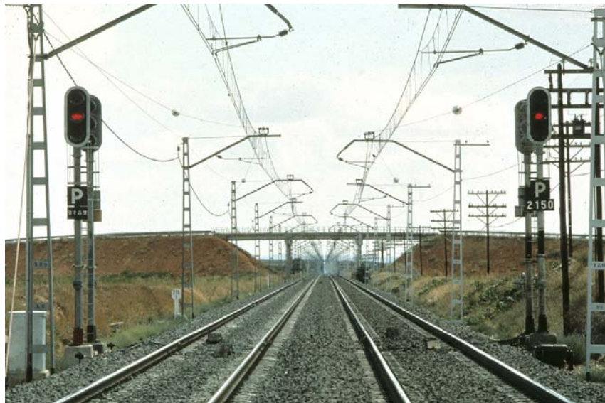
Figura 8. Vía doble banalizada
