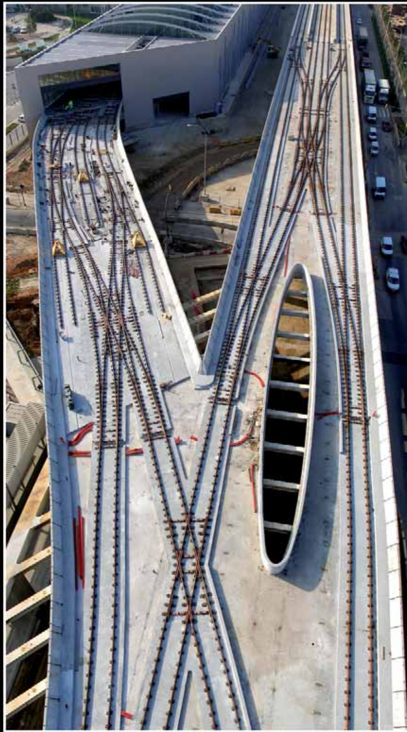
Montaje de desvíos en losa. Metro Barcelona, viaducto L-9
