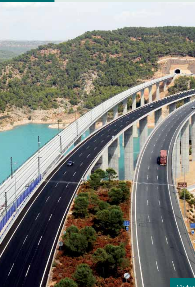
Viaducto del Istmo.
