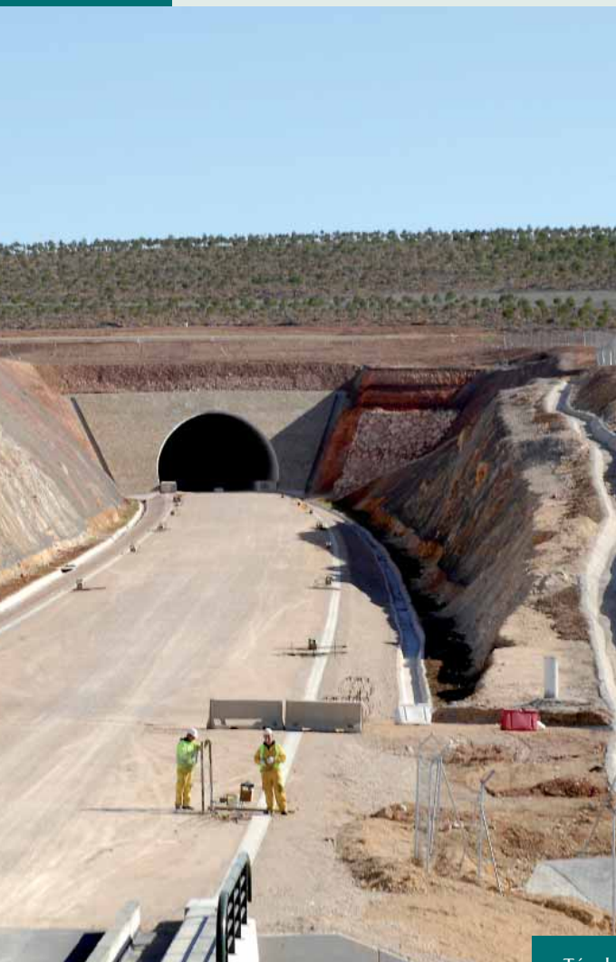
Túnel de Horcajada.
