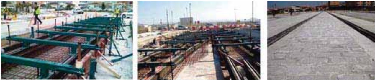
Figuras 15,16 y 17. Colocación de los carriles y desvío mediante pórticos; Vía hormigonada y acabado de adoquines.
