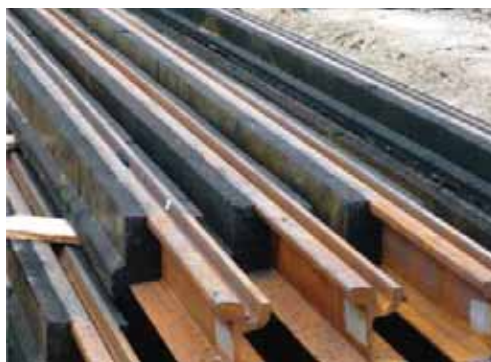
Figura 14. Vista general de la zona de acopio de carriles
