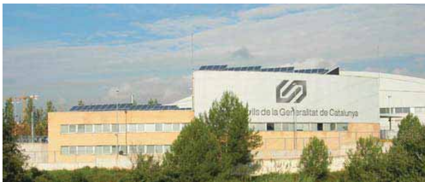
Fig. 7: Instalación fotovoltaica en el techo de las oficinas de los talleres de Rubí de FGC
