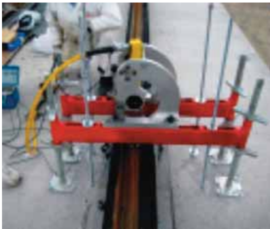
Figura 18. Auscultación de los carriles in situ previa al hormigonado
