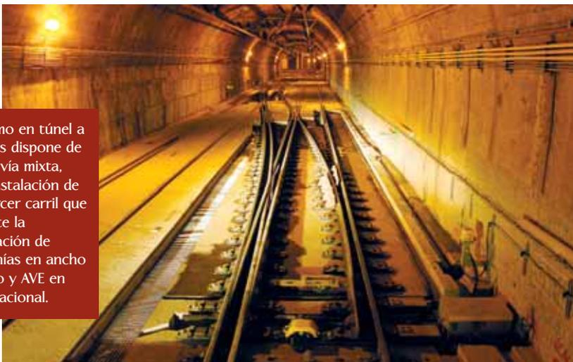
El tramo en túnel a Barajas dispone de doble vía mixta, con instalación de un tercer carril que permite la circulación de cercanías en ancho ibérico y AVE en internacional.
