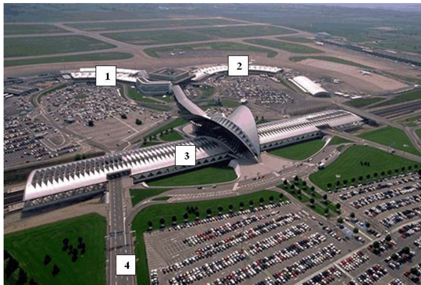
Figura 9: Aeropuerto de Lyon-St. Exupery
