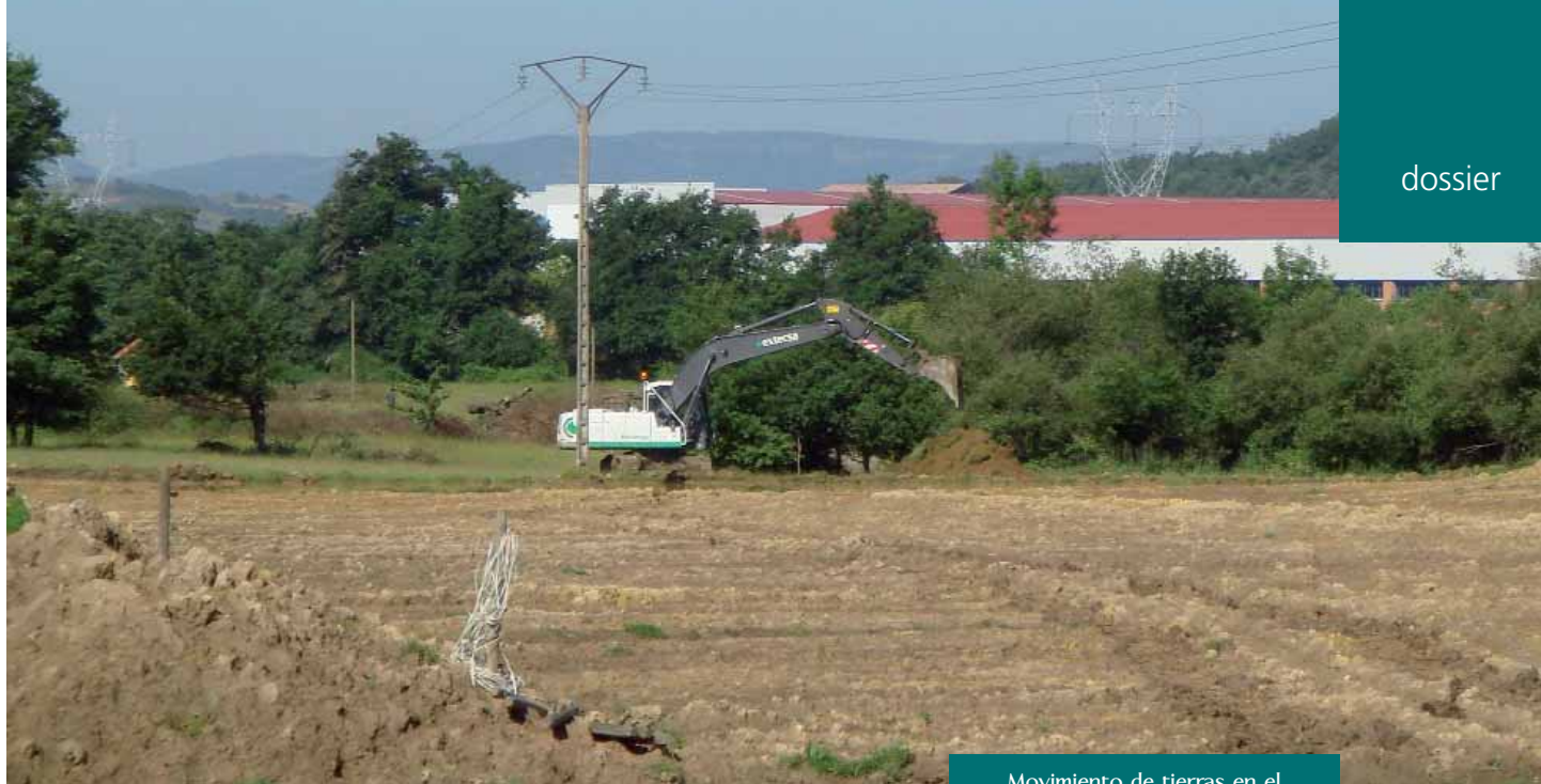
Movimiento de tierras en el subtramo I Legutiano-Eskoriatza.
