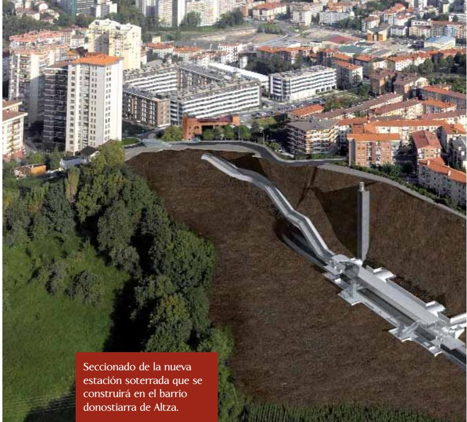
Seccionado de la nueva estación soterrada que se construirá en el barrio donostiarra de Altza.
