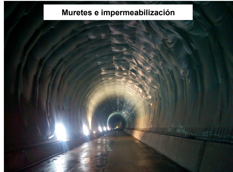
Impermeabilización, muretes y revestimiento
