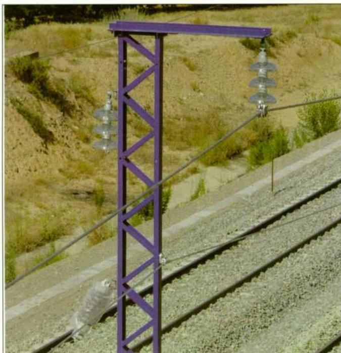
Las distancias mecánicas de seguridad entre el pantógrafo y cualquier parte de la instalación son superiores a las exigidas por la UIC. En ménsulas normales, la distancia entre el hilo de contacto y el tubo horizontal de atirantado es de 350 mm, y en ménsulas especiales la distancia se eleva hasta los 600 mm.
