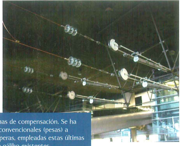
Antiguas ménsulas en zonas de gálibo reducido. A la derecha las nuevas ménsulas curvas para zonas de gálibo reducido.
