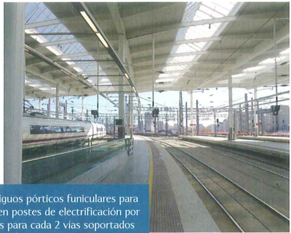
Modificación de estructuras soporte en zona sur de andenes. Sustitución de pórticos rígidos y mensulones por pórticos funiculares para cada caja de vías, sobre nueva estructura.
