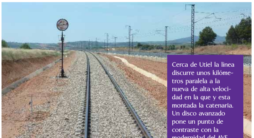
La entrada de la estación de Utiel lado Valencia presenta un configuración de vías clásica, con desvíos sobre madera e indicadores de posición de agujas.
