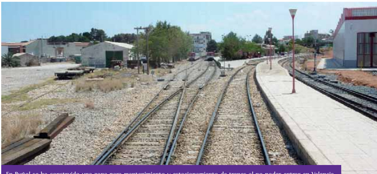
En Buñol se ha construido una zona para mantenimiento y estacionamiento de trenes al no poder entrar en Valencia.
