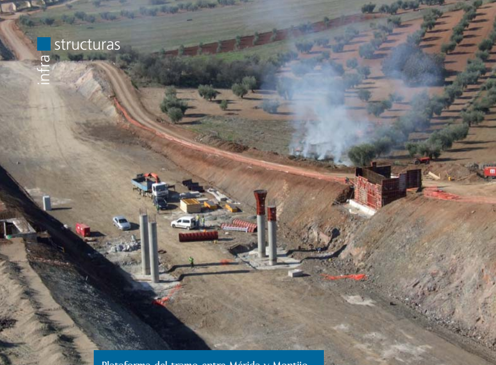
Plataforma del tramo entre Mérida y Montijo.
