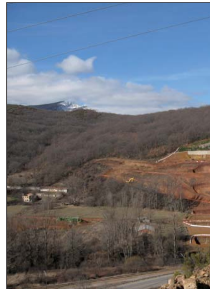
Viaducto de Huergas.
