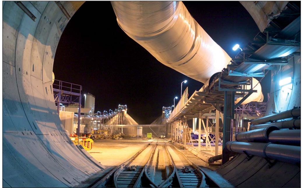
Emboquille del lote 1 del túnel.
