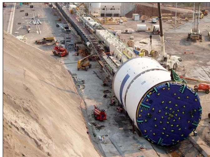
Montaje de la tuneladora.
