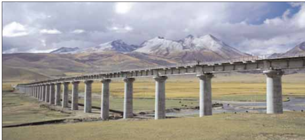
La línea a Lhasa atraviesa el Paso de Tangula, alcanzando una altitud de 5.072 metros.
