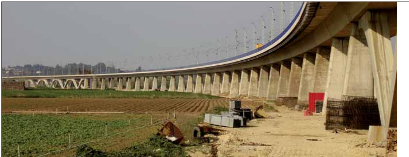
Trazado en curva del viaducto del Portal desde el plano de la vega del río Guadalete.
