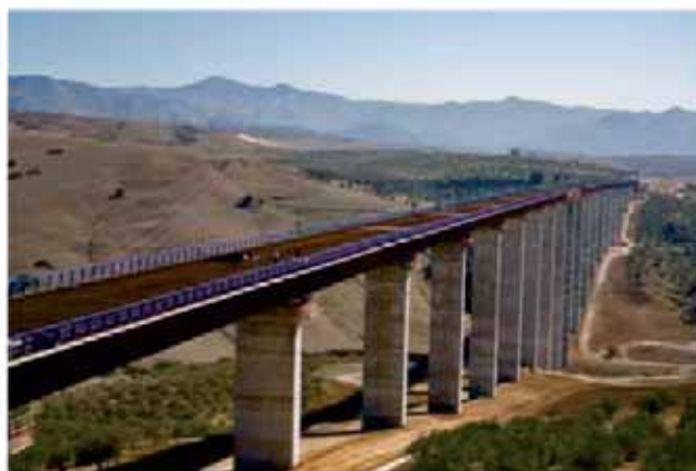
Línea de Alta Velocidad Córdoba-Málaga. Tramo: Bobadilla-Málaga
