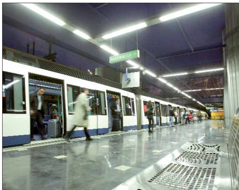
Estación de metro de Madrid en el aeropuerto.
