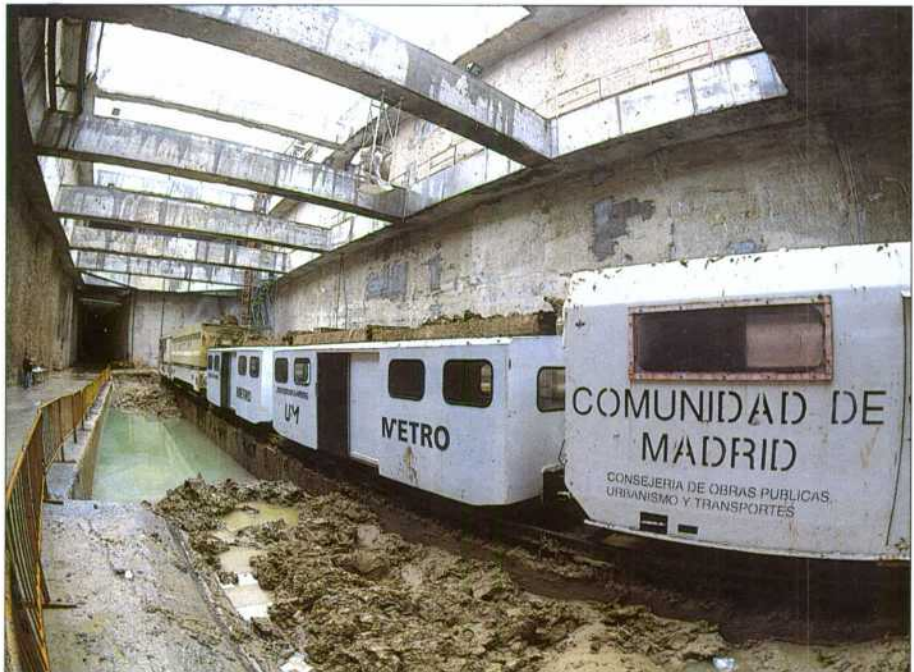
El volumen de excavación incrementa la complejidad técnica de la obra.
