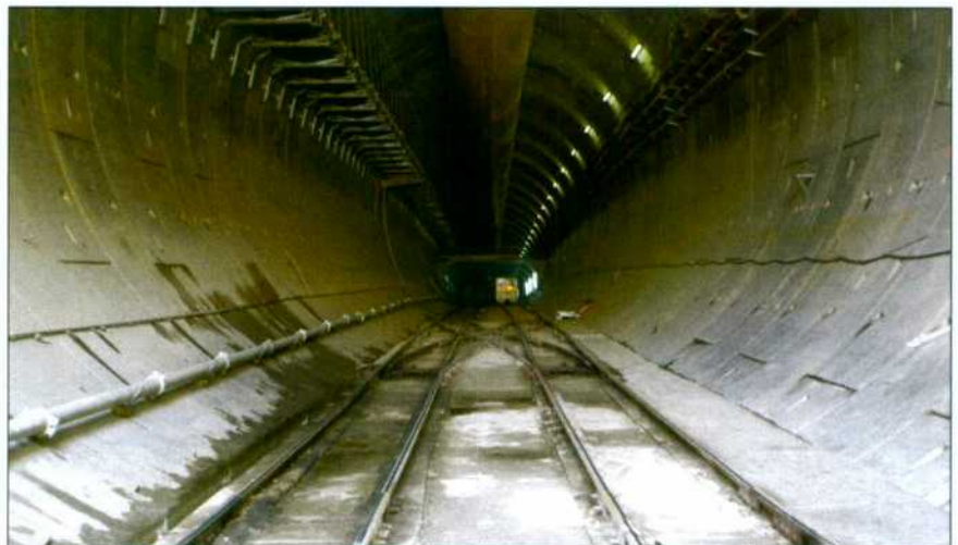
Sistema de transmisiones vía radio de imágenes y datos
