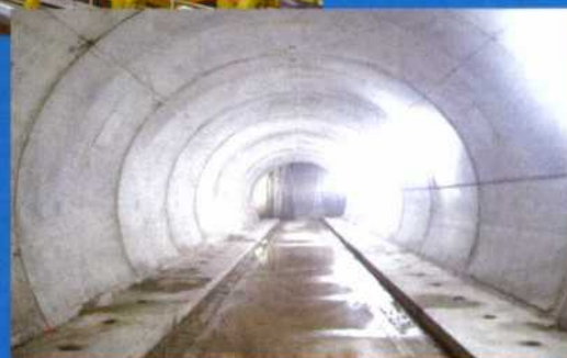
GALERÍA TRANSVERSAL REVESTIDA
