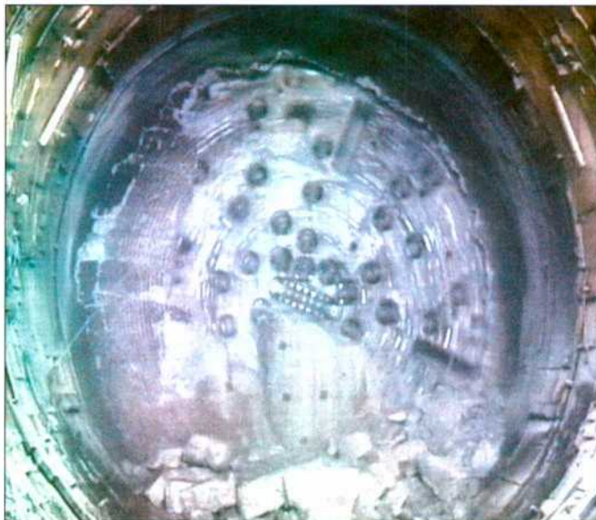
Avance la tuneladora en el momento del encuentro.
