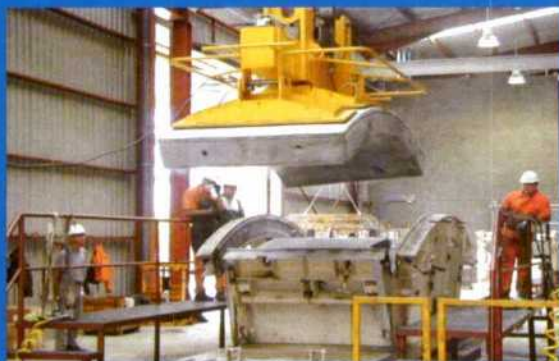
FABRICACIÓN DE DOVELAS
