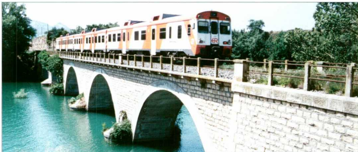
Puente sobre el lago de San Antonio en el municipio de Salas de Pallars.
