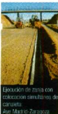
Zanja con colocación simultánea de conductos eléctricos
