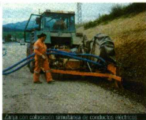
Zanja con colocación simultánea de conductos eléctricos
