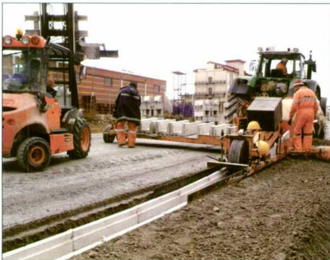
Colocación de canaleta con el sistema de Aples.
