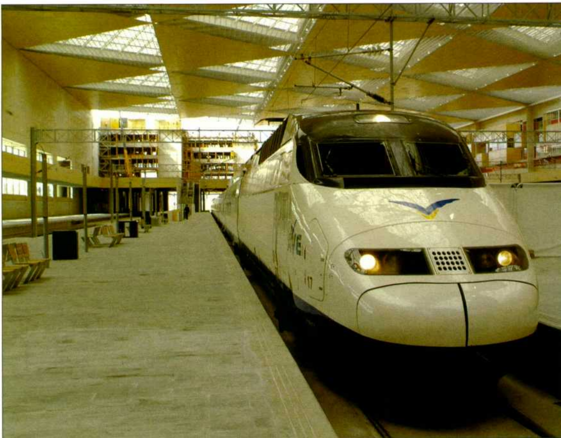
Nueva estación de Delicias, con un AVE en pruebas.
