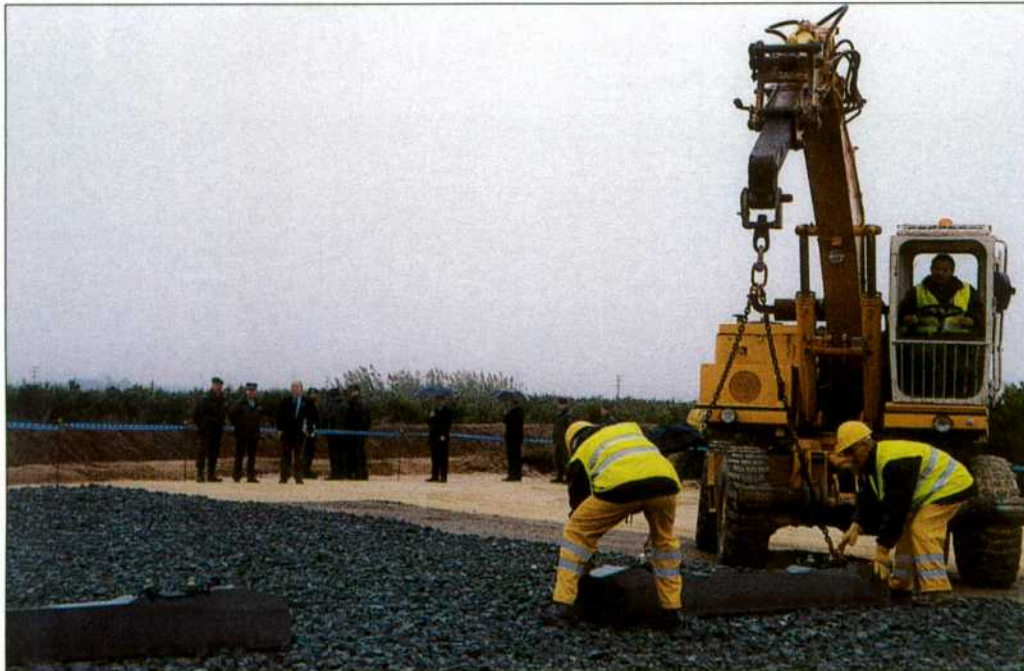
Colocación de las primeras traviesas de alta velocidad en Picassent.
