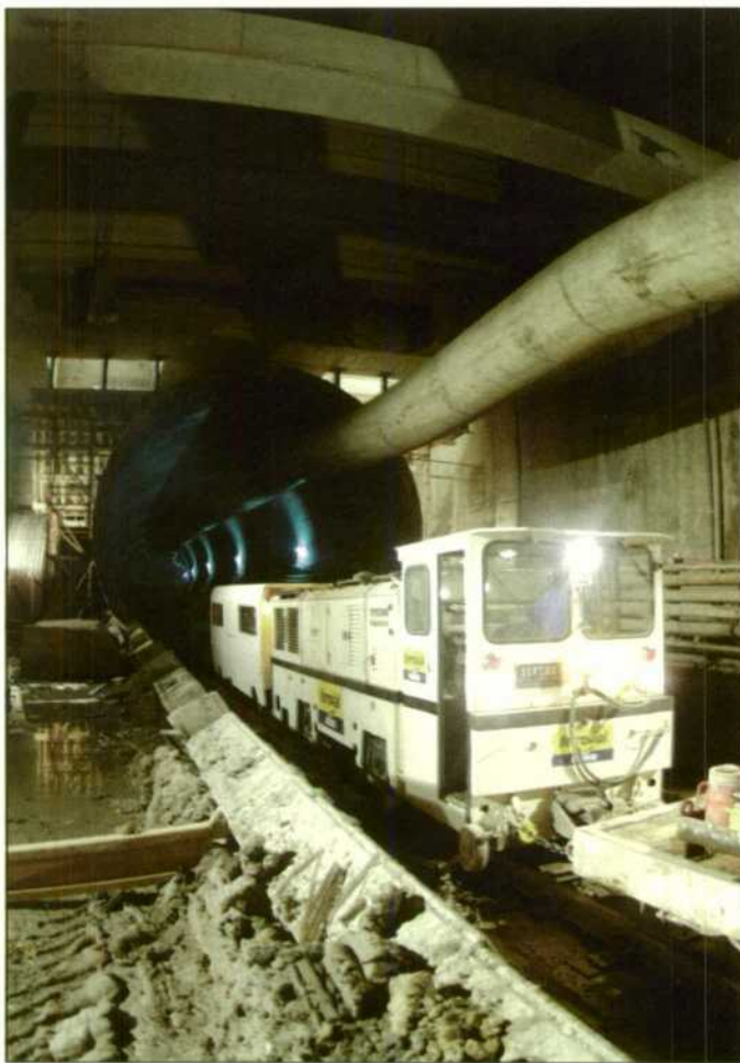
El coste por kilómetro excavado es de tan sólo 33 millones de euros.
