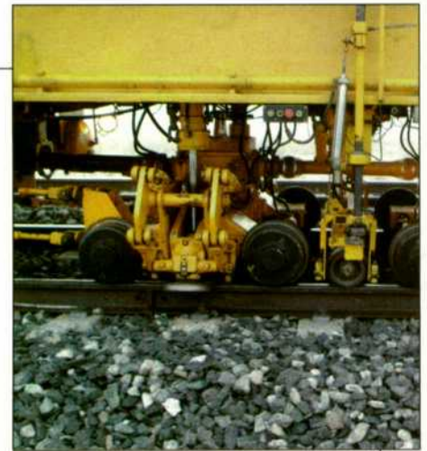
Detalle de estabilizado de carril.
