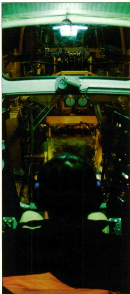
Trabajo de bateo desde la cabina.
