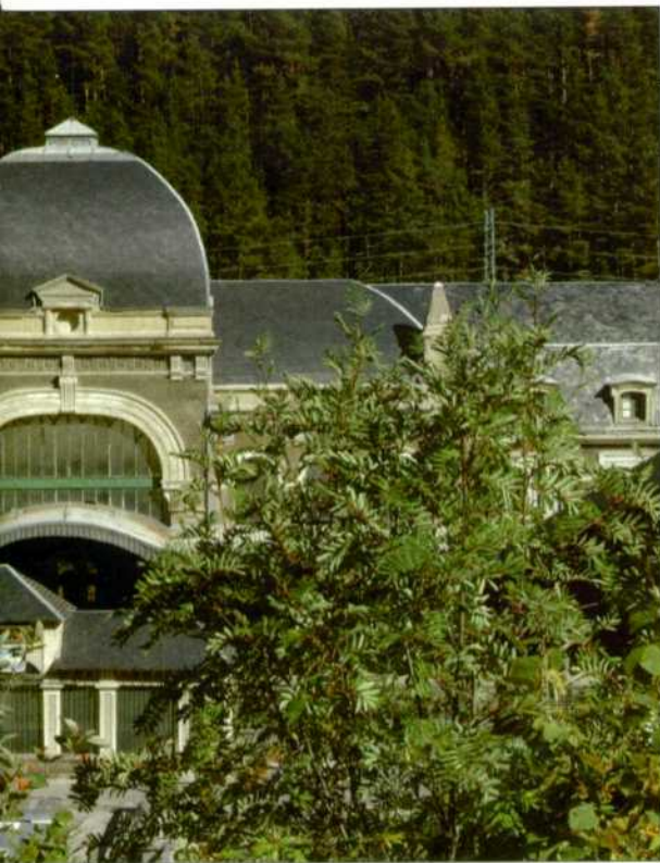
Estación ferroviaria de Canfranc.
