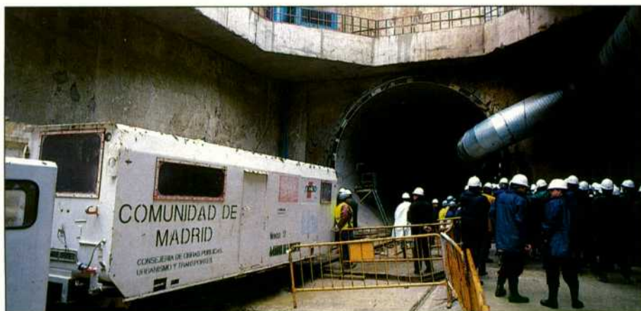
Entrada al túnel en obras.
