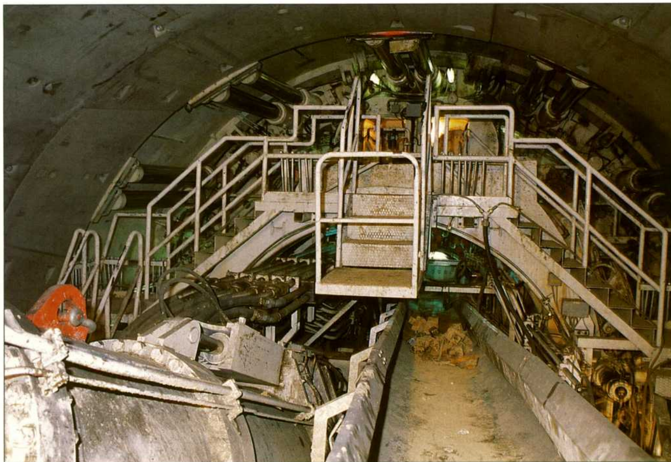
Máquina tuneladora en los trabajos de la nueva conexión al aeropuerto.
