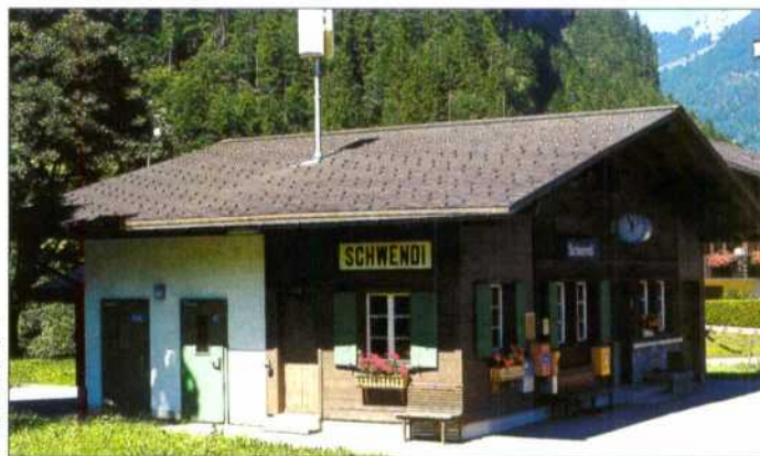
Estación-chalet de Schwendi. En primer término, una nueva aguja aguarda el momento de ser instalada.
