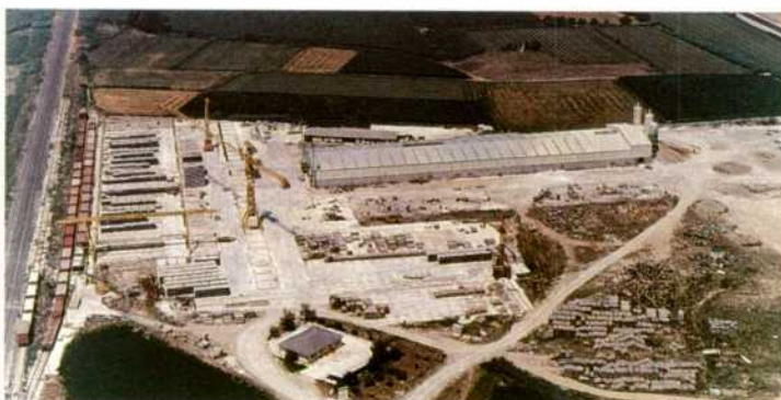
Fábrica de traviesas de hormigón de Luceni (Zaragoza)
