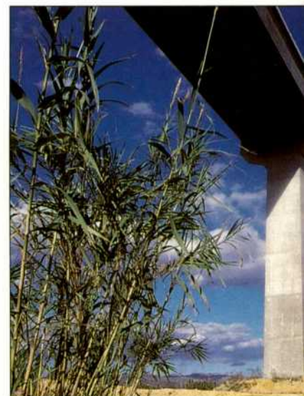
Viaducto del Ebro.
